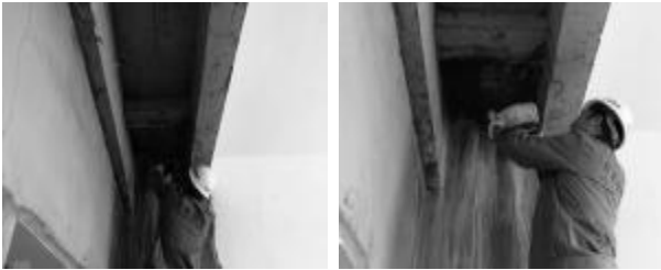
图 2 顶板渗漏缺陷处理 图 3 喷涂 YYA 抗渗材料
