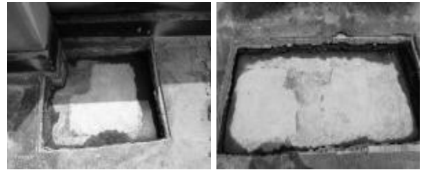
图 6 细节部位的基面清理与高压水喷洗
