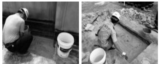
图 7 基面涂 YY36 耐候涂料封闭
