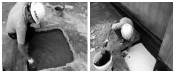
图9 涂铺粘结料并铺设卷材
