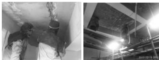
图 2 裂缝基面处理和施工缝基面腻子铲除
