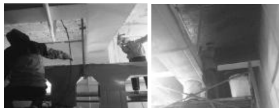
图 4 裂缝补强后喷涂 YYA 特种防水抗渗浆料
