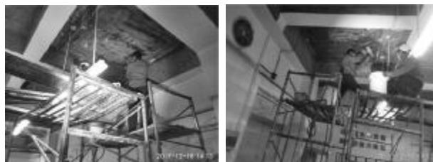
图 3 节点和整面喷涂 YYA 特种防水抗渗浆料
