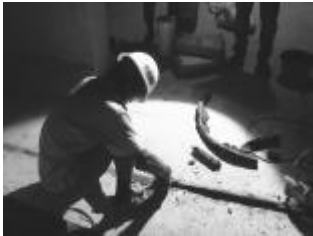
图 3 挖取聚硫密封胶
