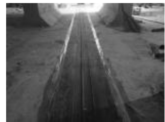
图 11 底板贴隔离胶带
