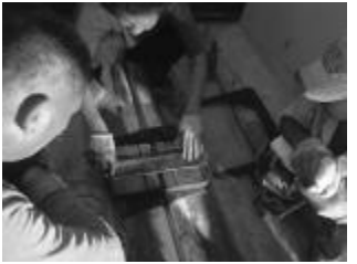
图 14 整齐摆放连接胶条
