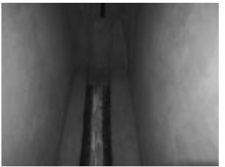
图 12 侧墙、顶面贴隔离胶带
