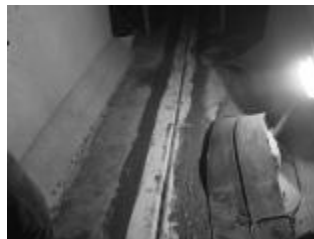
图 8 粘结密实的伸缩缝
