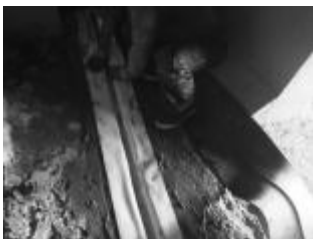
图 7 粘贴冗余防水密封带
