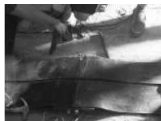
图 17 延长段止水带熔接完成
