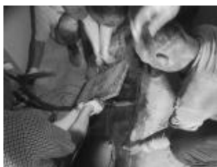
图 15 熔接延长段止水带
