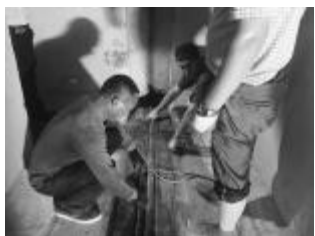
图 19 安放十字接头止水带
