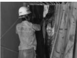
图 20 侧墙缝涂抹聚硫密封胶
