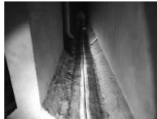
图 9 底板密封带涂 RD-DT 封闭
