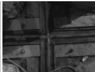
图 23 十字接头钢板固定
